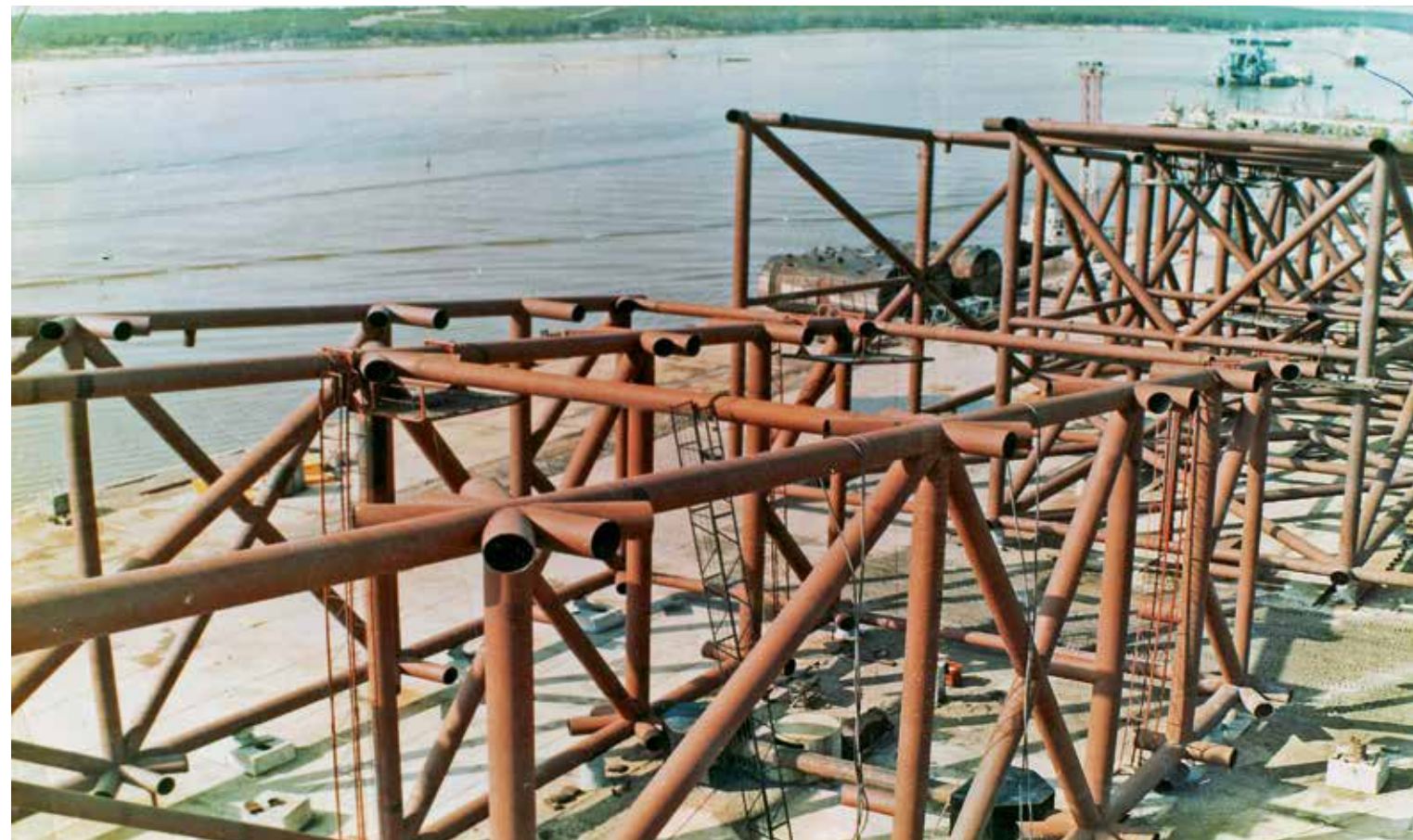
Liên Xô bắt đầu chế tạo các cụm thiết bị cho nền giàn khoan cố định trên biển
