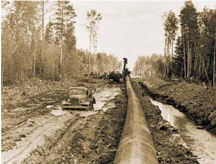
Xây dựng đường ống dẫn dầu ở Siberi những năm 1960
