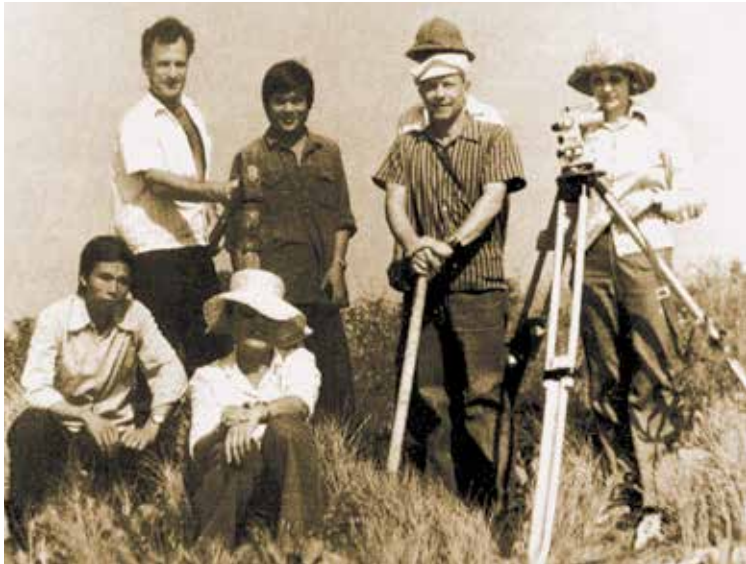
Các cán bộ khảo sát lộ trình đường ống
