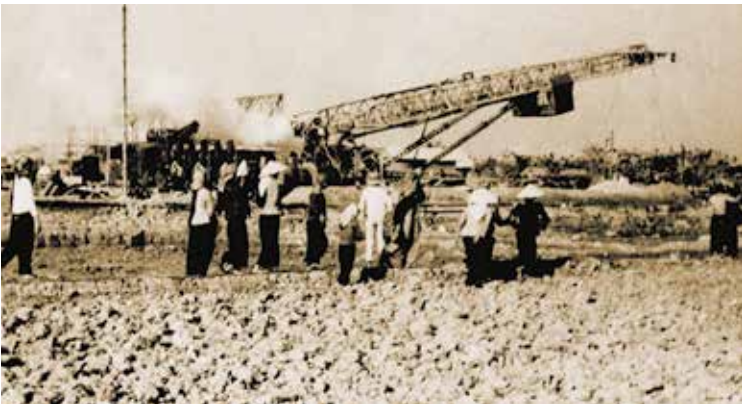
Lắp đặt tháp để khoan giếng sâu
