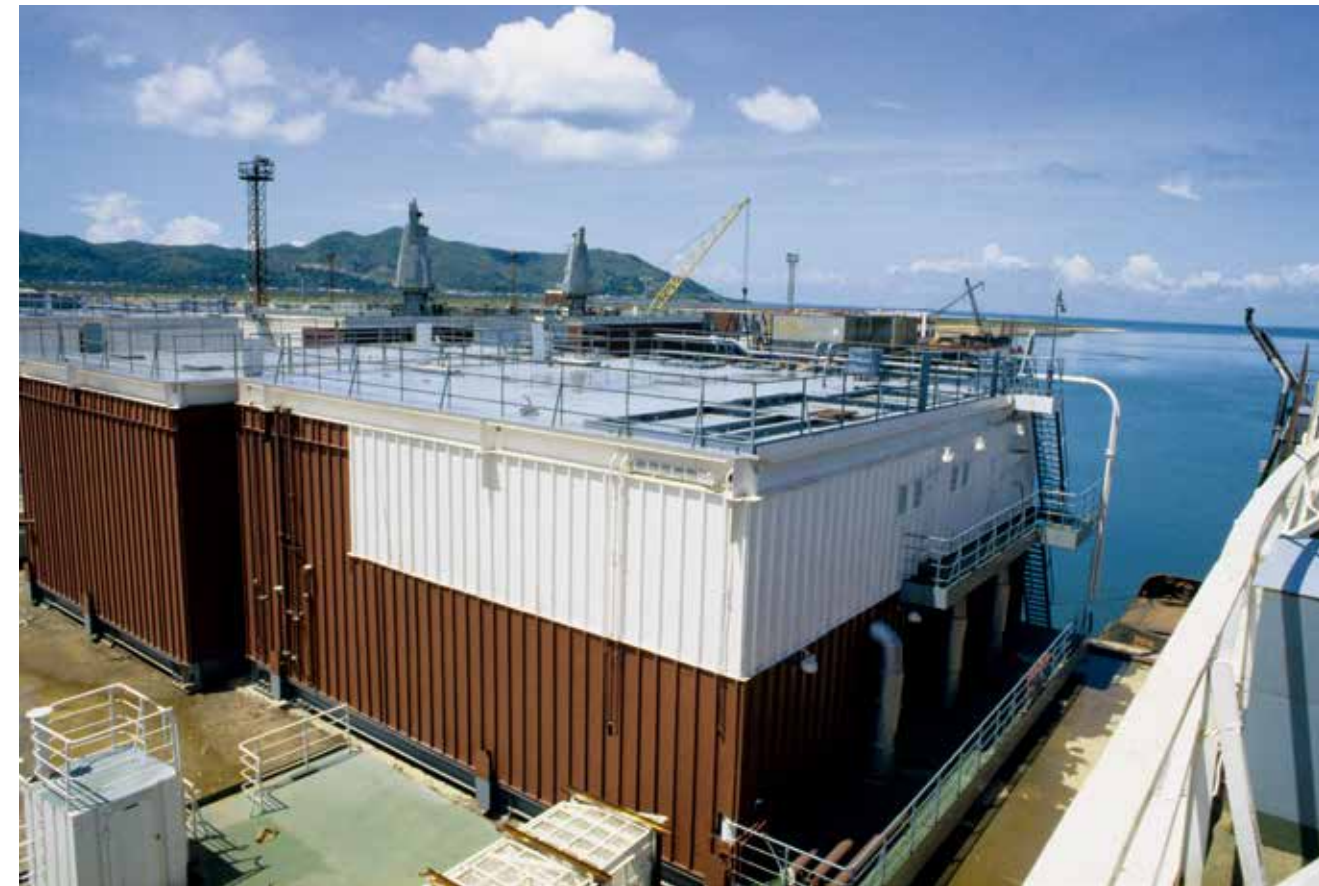
Các khoang kết cấu thượng tầng cho các giàn khoan biển cố định đang chờ lắp ráp RIA Novosti
