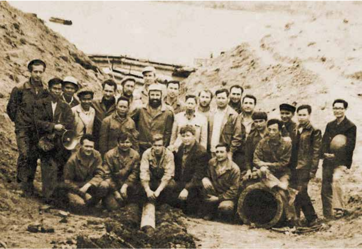
Các chuyên gia Xô-viết và Việt Nam sau khi hoàn thành thắng lợi công trình xây dựng đoạn đường ống ngầm dẫn dầu tuyến Bãi Cháy — Phú Lý vượt qua sông Hồng. Năm 1971
