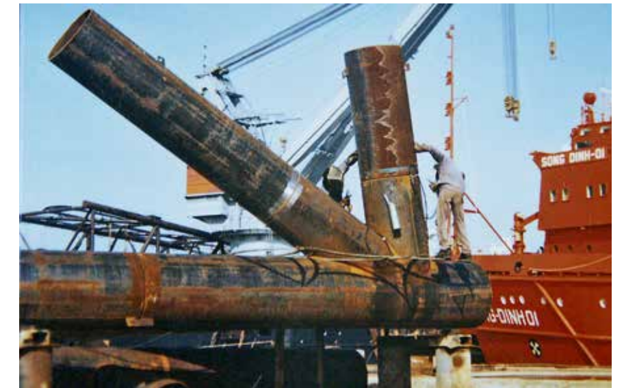
Lắp các cụm thiết bị lại Vũng Tàu
