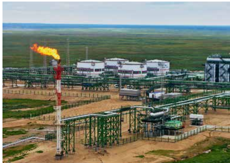
Tại công trình của Công ty liên doanh RusVietpetro
