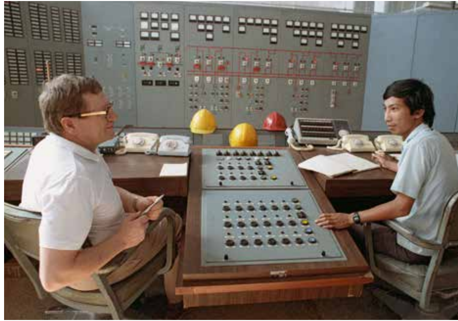
Bên khoang điều khiển của nhà máy Thủy điện Trị An. Năm 1980 RIA «Novosti»
