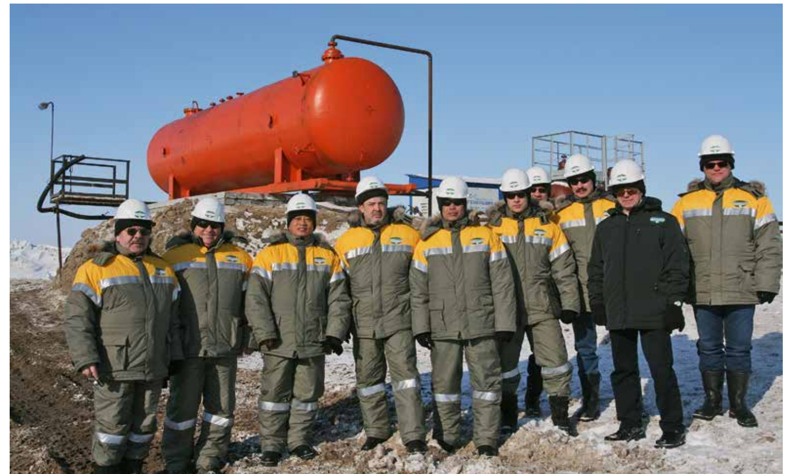
Lãnh đạo Zarubezhneft và PetroVietnam tại công trường xây dựng Trạm thu hồi dầu trung tâm của các mỏ thuộc đới Trung Khoreyverskoie tại Khu tự trị Nenetsky. 2009 Ảnh tư liệu của Zarubezhneft
