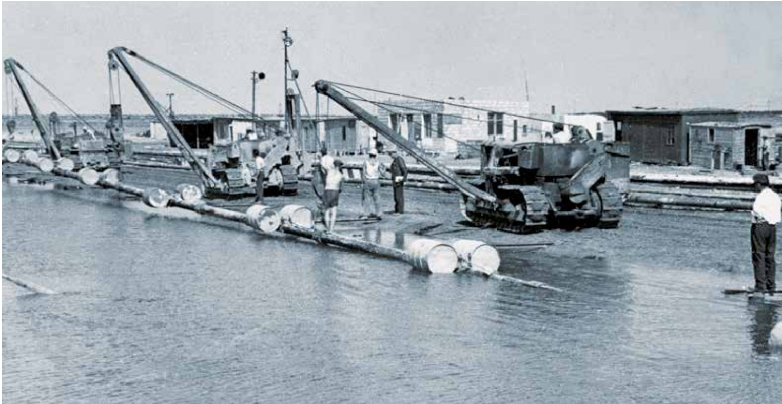
Liên Xô xây dựng những đường ống dẫn dầu đầu tiên qua biển ở Biển Caspi
