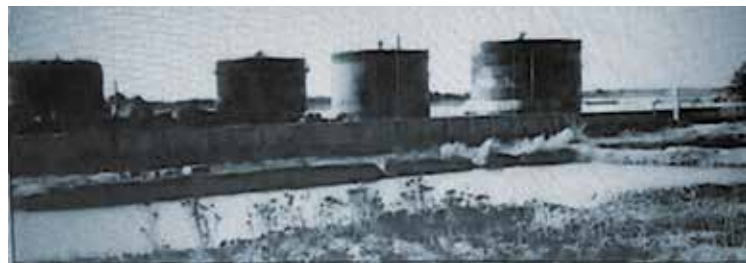
Kho xăng dầu ở thành phố Vinh
