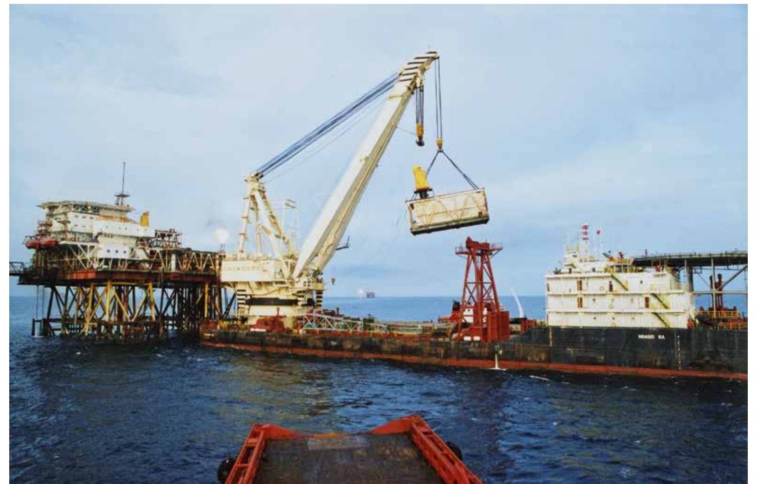
Cần cẩu nổi «Trường Sa» đang chuyển super — block sang giàn khoan cố định để tiếp tục lắp đặt
