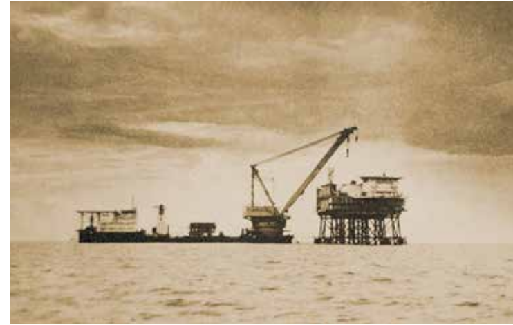
Xây dựng giàn khoan cố định số 1. Năm 1984
