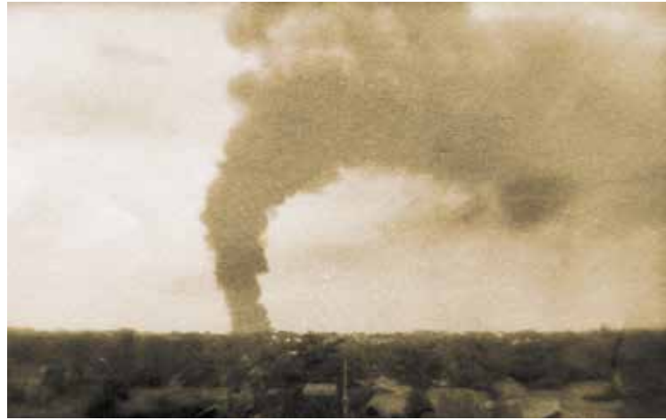
Kho chứa dầu của Hà Nội đang bốc cháy
