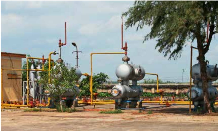
Hệ thống bình tách khí hiện nay tại Xí nghiệp khí Tiền Hải. 2015
