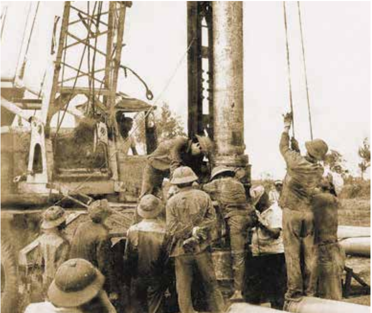
Xây dựng cơ sở phục vụ máy khoan
